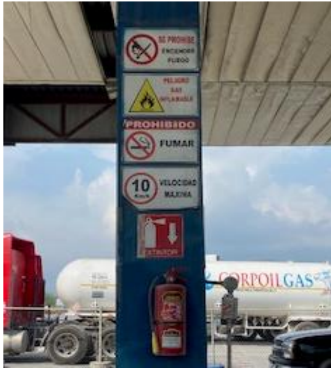
Figura 8. Señalización y equipo de emergencia en la isleta de carburación
