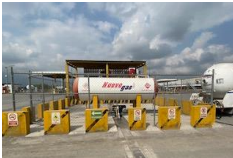
Figura 2. Área de almacenamiento con recipiente de almacenamiento 5,000 L
