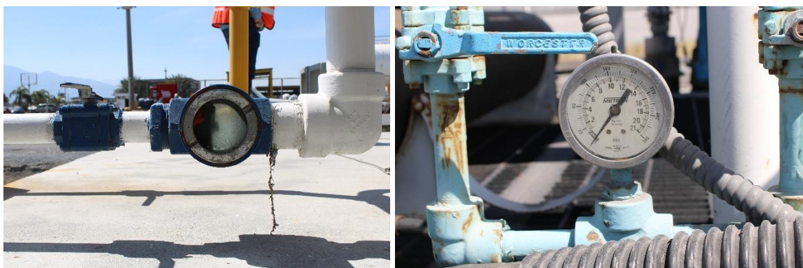
Figura II.3. Indicador visual y manómetro en la línea de gas-líquido.
