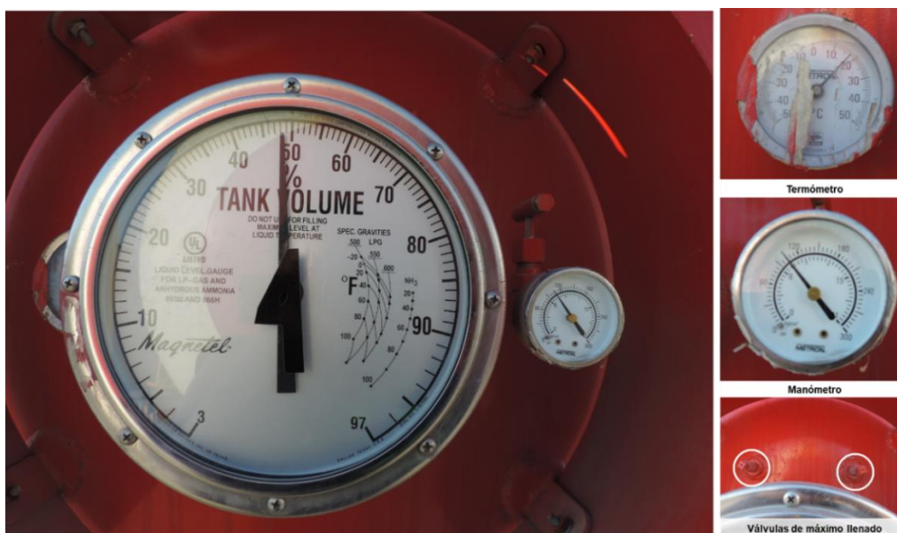
Figura II.8. Termómetro, manómetro y válvulas de máximo llenado del recipiente de almacenamiento Núm. IV.
