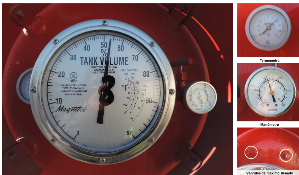
Figura II.7. Termómetro, manómetro y válvulas de máximo llenado del recipiente de almacenamiento Núm. III.
