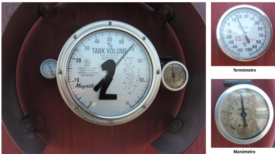
Figura II.6. Termómetro y manómetro del recipiente de almacenamiento Núm. II.
