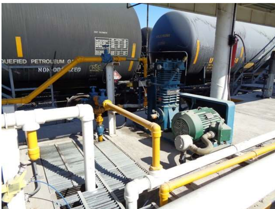
Figura 2.- Área de compresores y espuelas de ferrocarril.
